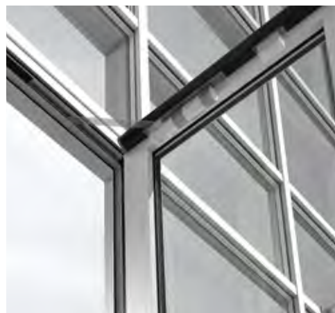
Schüco integrierter Drehtürantrieb ID 160 Schüco Встроенный привод поворотной двери ID 160
