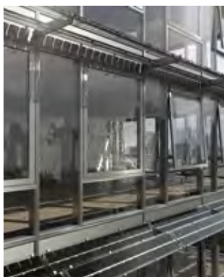
Schüco Fassade USC 65 mit Schüco Großlamellen ALB aus Glas Schüco Фасад USC 65 с широкими ламелями Schüco ALB из стекла
