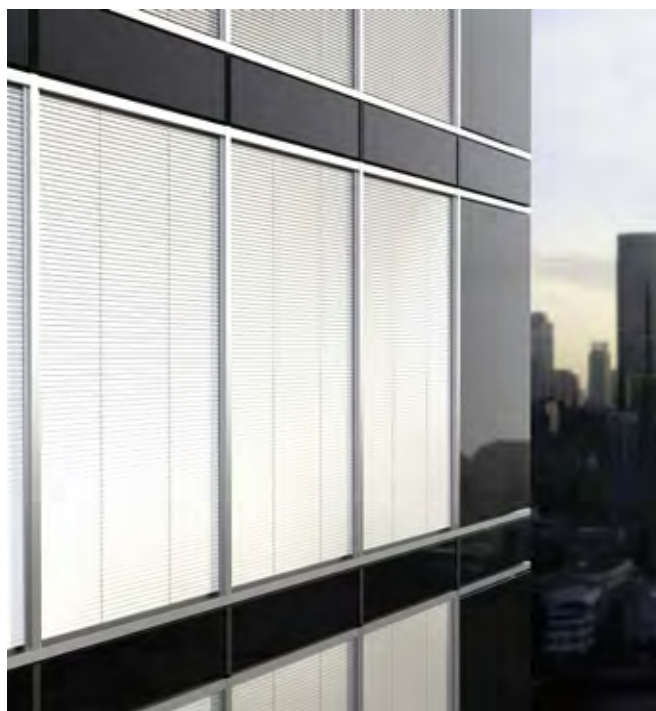
Schüco Sonnenschutz CAB heruntergefahren und mit geschlossenen Lamellen Солнцезащита Schüco CAB в опущенном состоянии и с закрытыми ламелями
