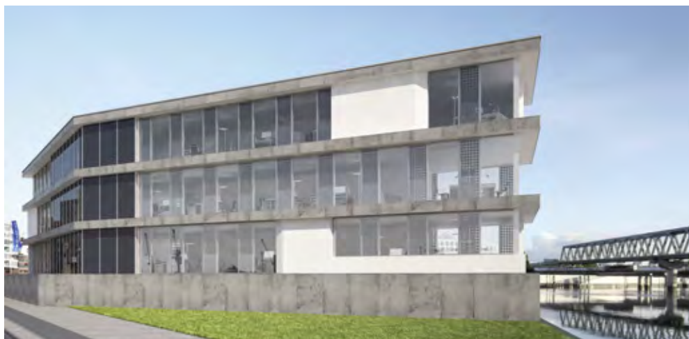
Schüco Fassade FWS 60 mit bauwerksintegrierter Photovoltaik Schüco Фасад FWS 60 со встраиваемыми в здание фотогальваническими модулями
