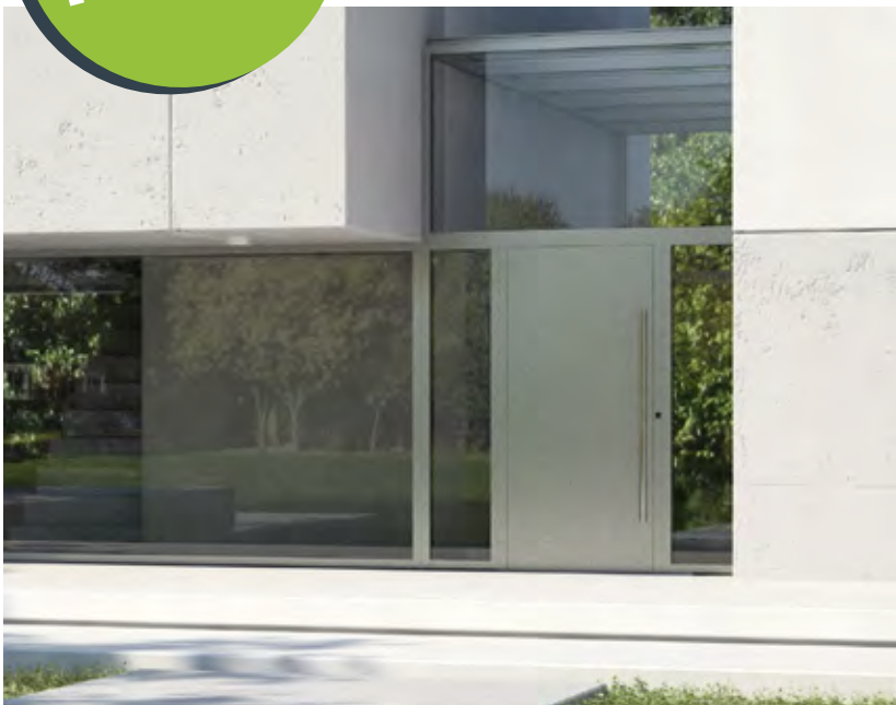
Privater Wohnbau Частный жилой дом
