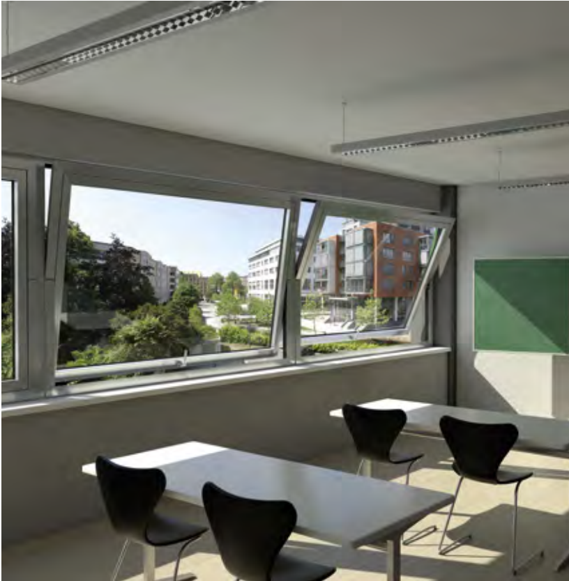
Schwingflügel – ideale Raumlüftung durch hohe Luftwechselrate Среднеподвесные окна с гориз. осью – идеальное проветривание благодаря оптимальному воздухообмену
